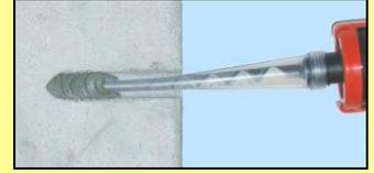
6. Unter leichter Drehbewegung Verankerungselement bis zum Bohrlochgrund eindrehen. Markierung auf dem Verankerungselement beachten.
